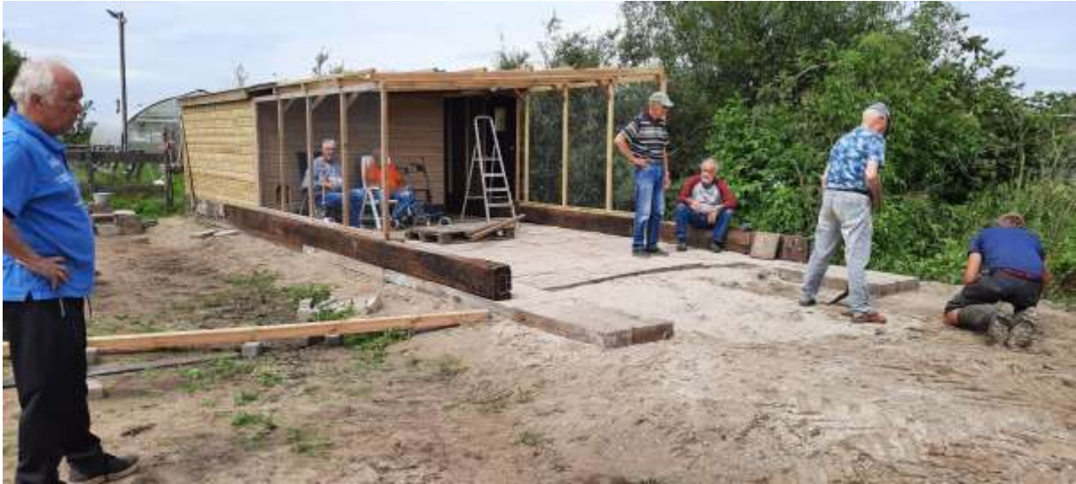
Het hele bouwwerk wordt op bielzen gezet. Zo is alles wat hoger en stoot niemand zijn hoofd!
