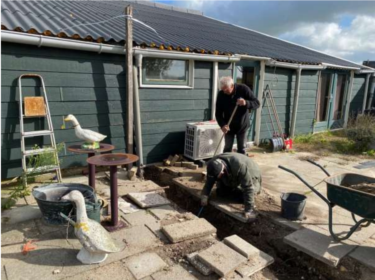
In voorbereiding op de heg in de kantine tuin moesten alle stenen uit de grond gehaald worden.
