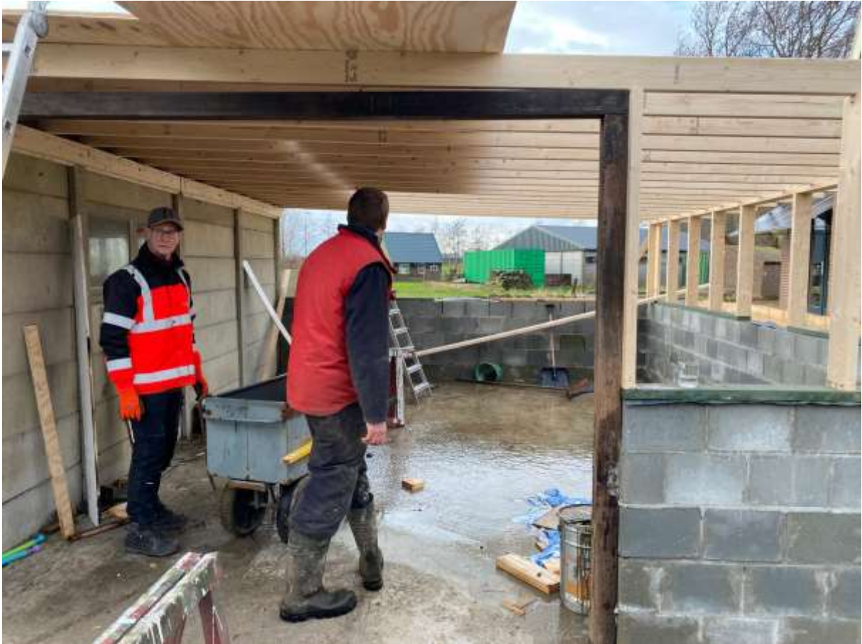
Het dak van het schuurtje ligt er op.
