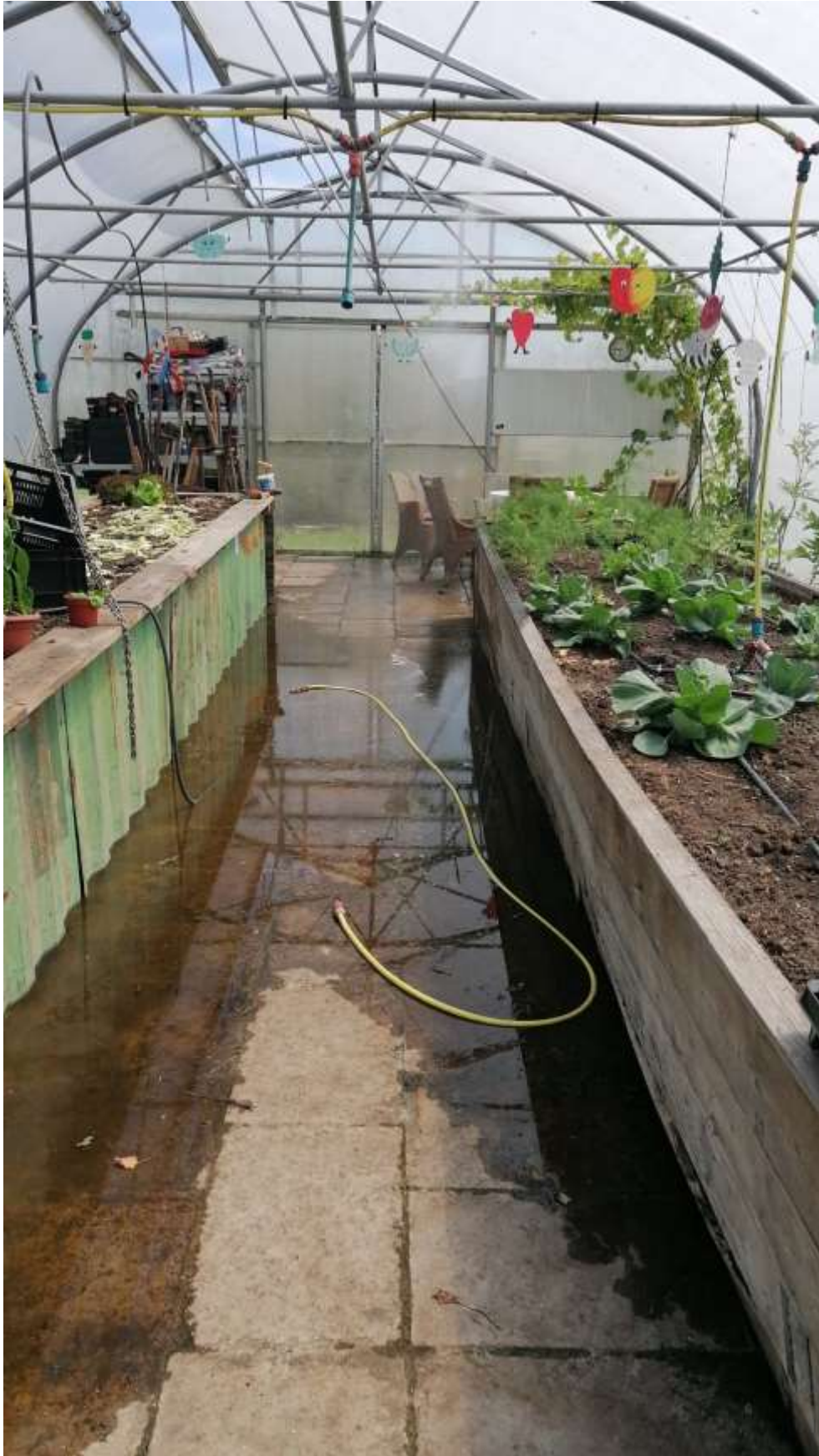
Lekkage aan een waterslang, oeps.
