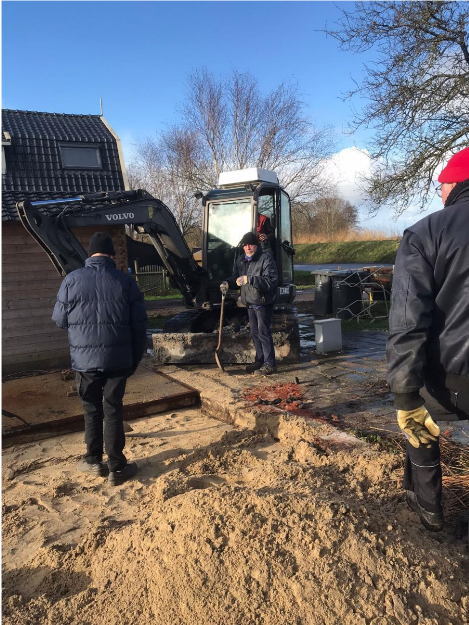
Voordat het rustpunt huisje neergezet werd, werden en stelcon platen gelegd voor een goede ondergrond.
