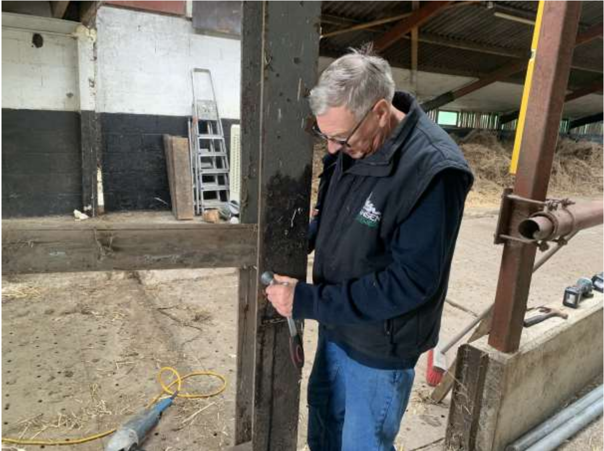
De bout wordt vastgezet zodat die paal er op kan blijven liggen.
