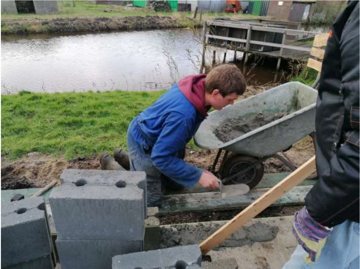
Mark is begonnen met het metselen van de nieuwe fietsenschuur.
