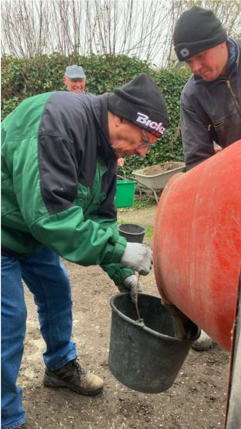
Hier wordt beton gemaakt voor de fundering.
