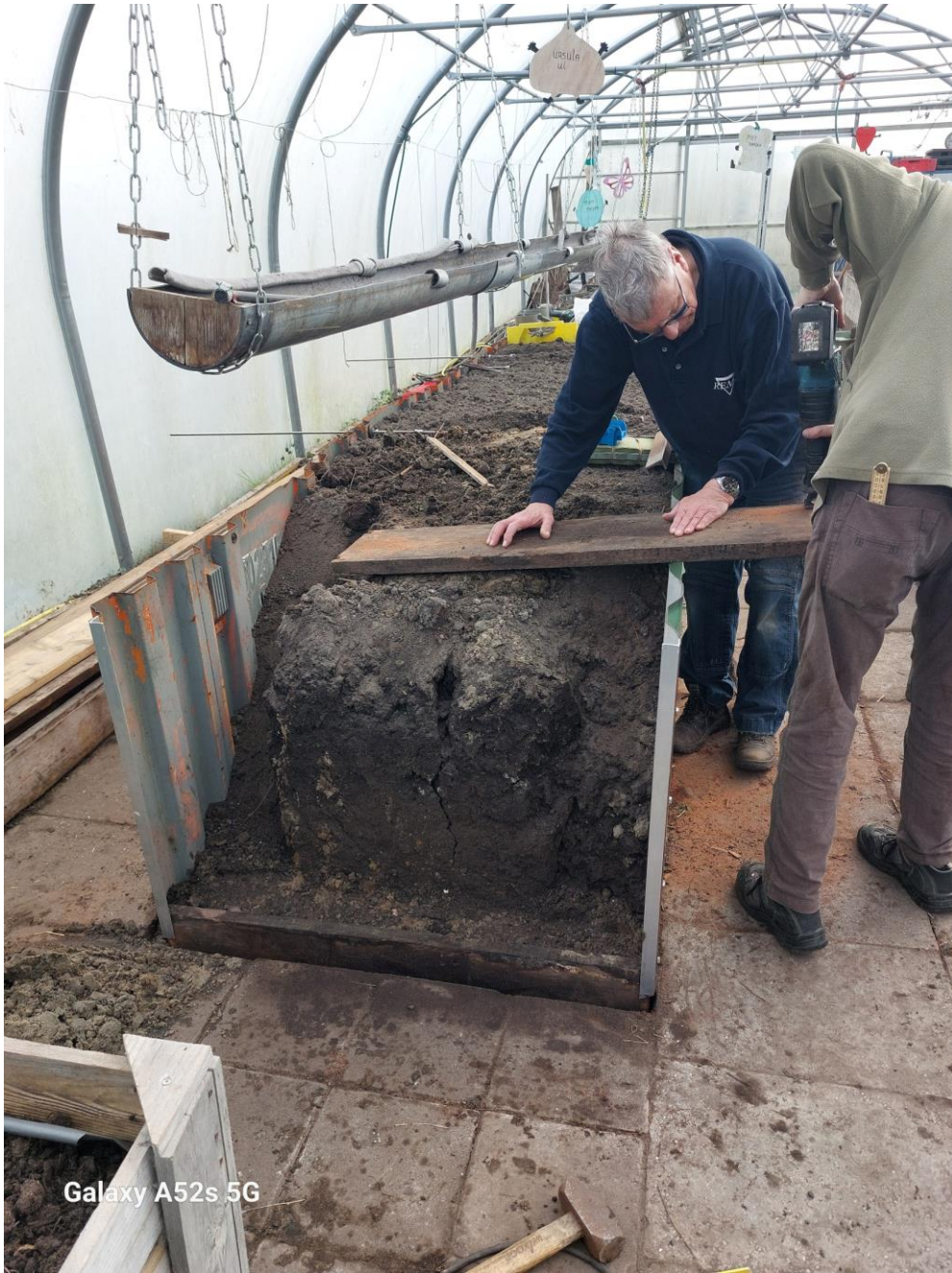
De kopse kant van de bak wordt dicht gemaakt met houten planken.
