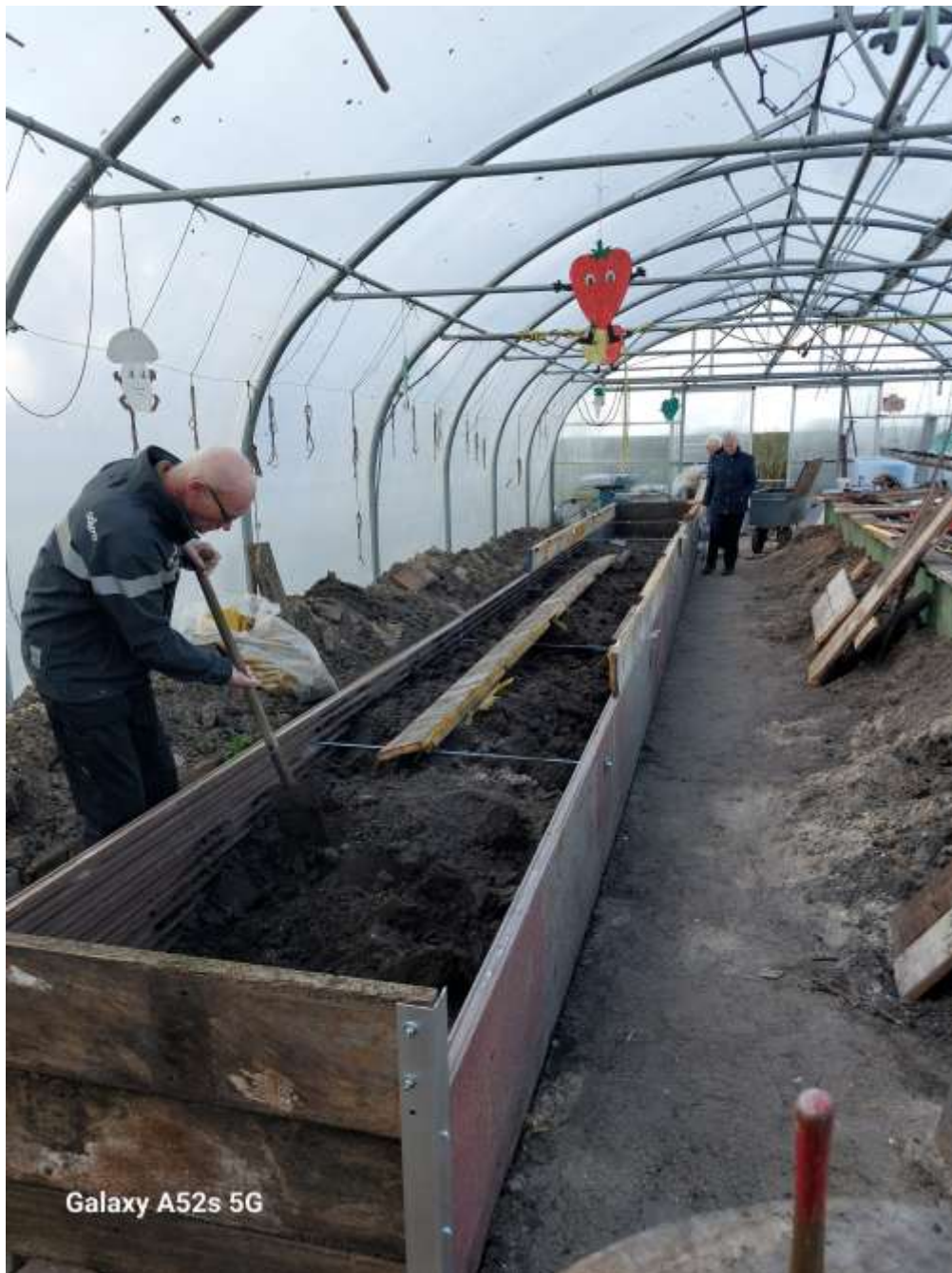
In de kas wordt nog hard gewerkt aan het vervangen van de hoge bak.
